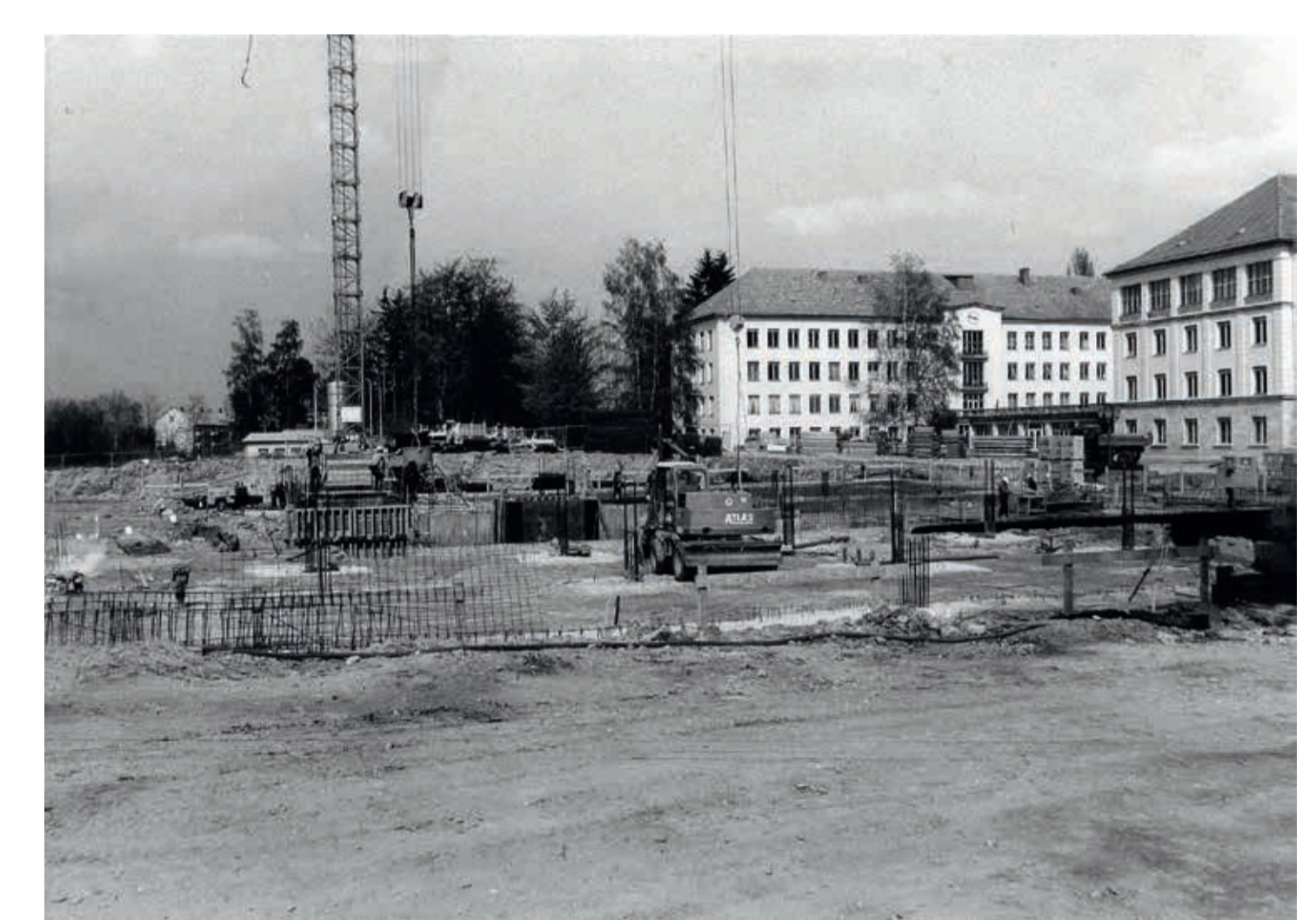
Baubeginn des Intensivmedizinischen Zentrums, 1992
