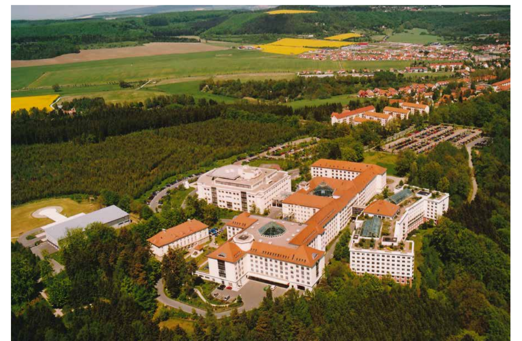
Luftbild der Zentralklinik – Hangar mit Landeplatz fertiggestellt (links)
