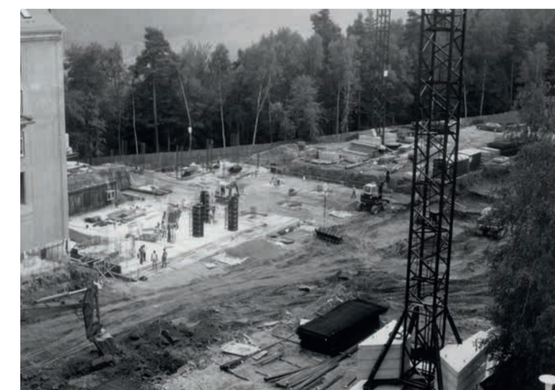
Bauarbeiten am Westtrakt (Foto: Studio-Neumann, Apolda, 1996)
