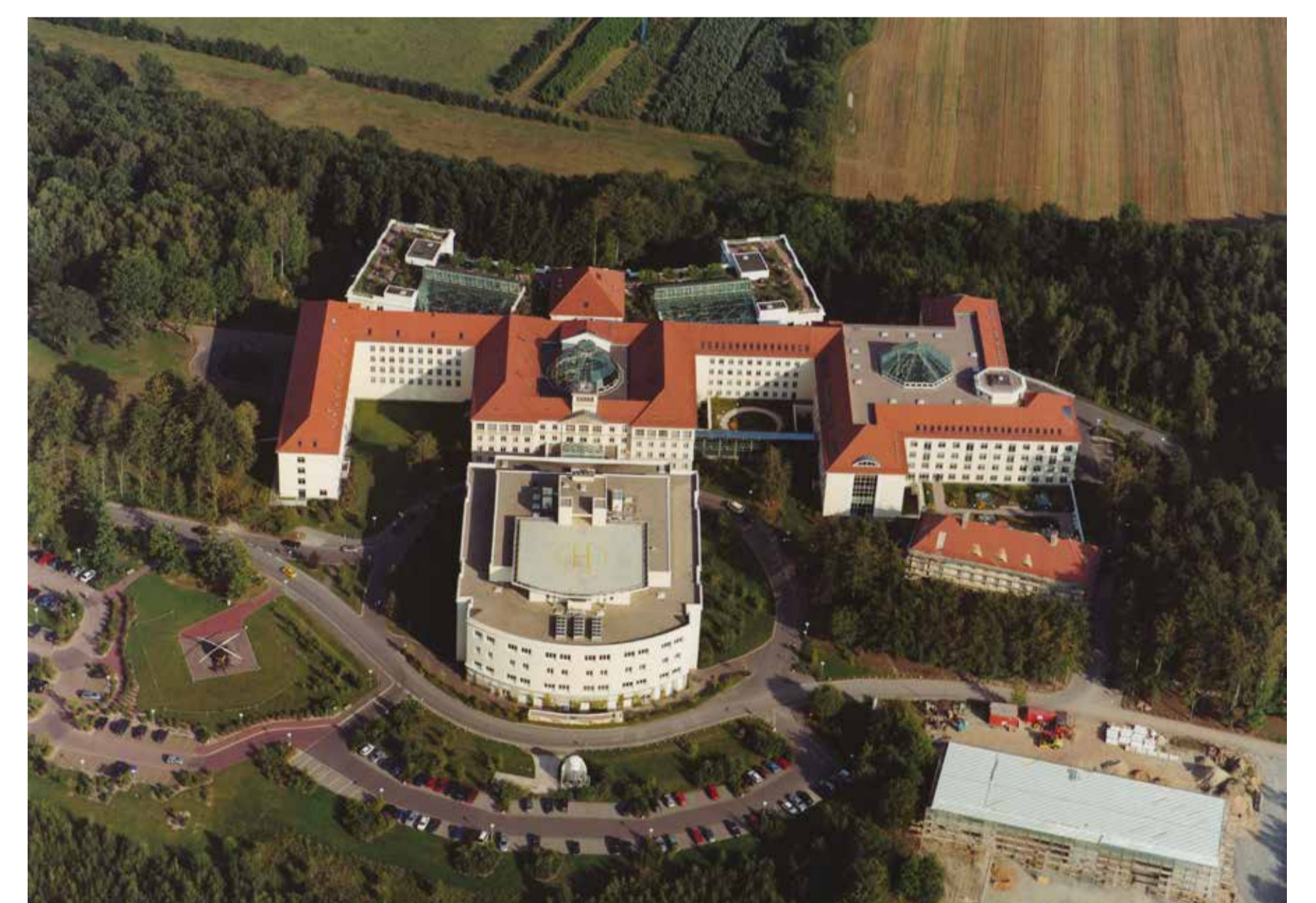
Luftbild der Zentralklinik – Hubschrauberhangar im Bau (vorn rechts), darüber Kulturhaus in der Sanierung und Westtrakt
