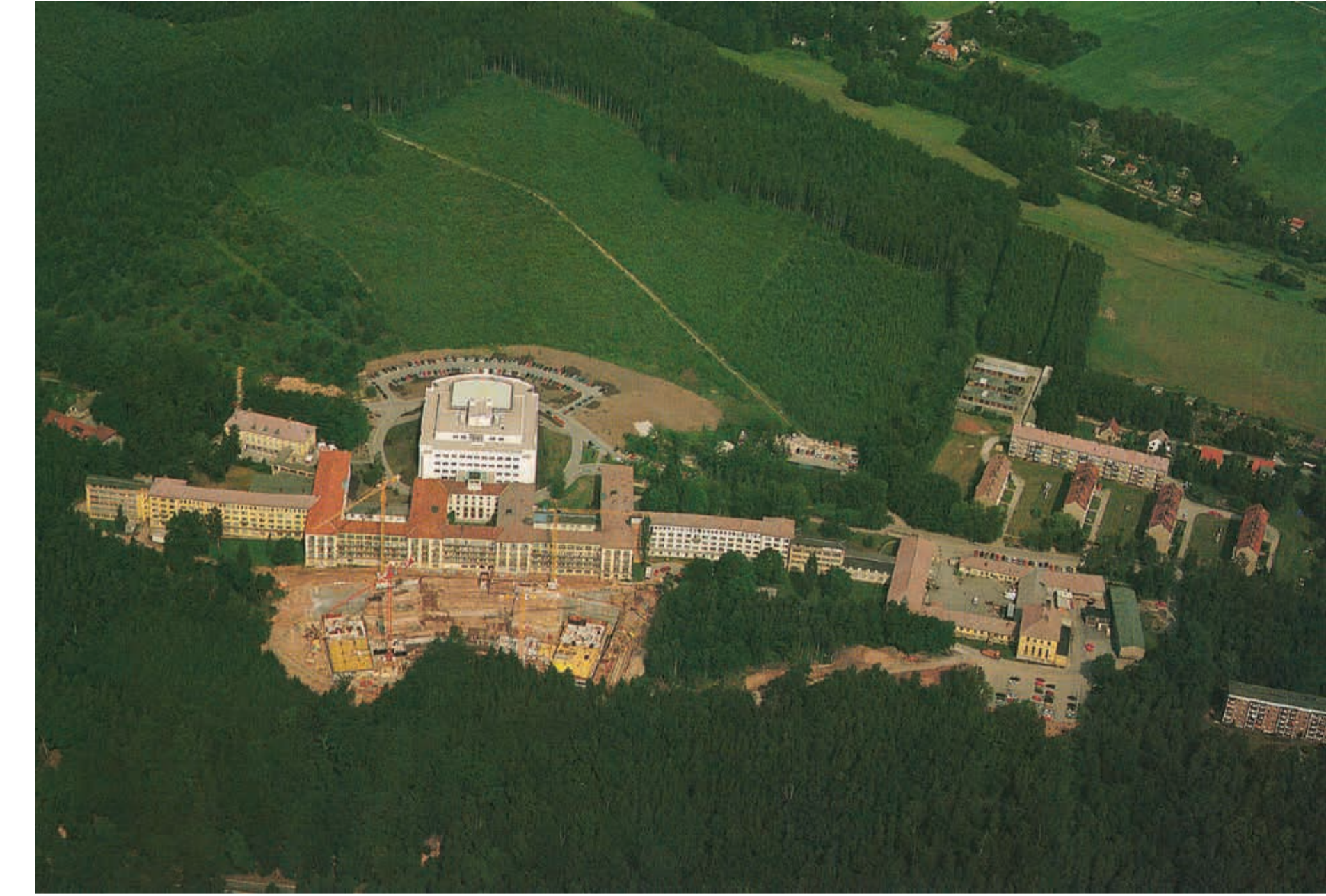
Baugrube des neuen Bettenhauses und das OP-Gebäude Postkarte (Foto: Schwabenflugbild, 1994)
