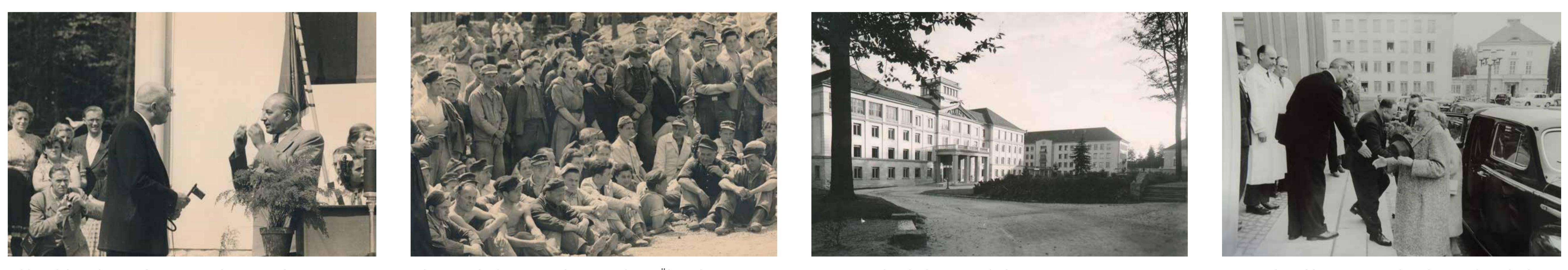
Schlüsselübergabe - Prof. Tegtmeyer übernimmt den 1. Bauabschnitt der neuen Klinik am 26. Mai 1954 Fritz Haase Lichtbildwerkstätte Bad Berka Arbeiter und Arbeiterinnen beim Festakt zur Übergabe des 1. Bauabschnitts am 26. Mai 1954 Fritz Haase Lichtbildwerkstätte Bad Berka Das Hauptgebäude der neuen Klinik um 1959 Otto Grothewohl, Ministerpräsident der DDR, besucht die TBC-Klinik, 1959
