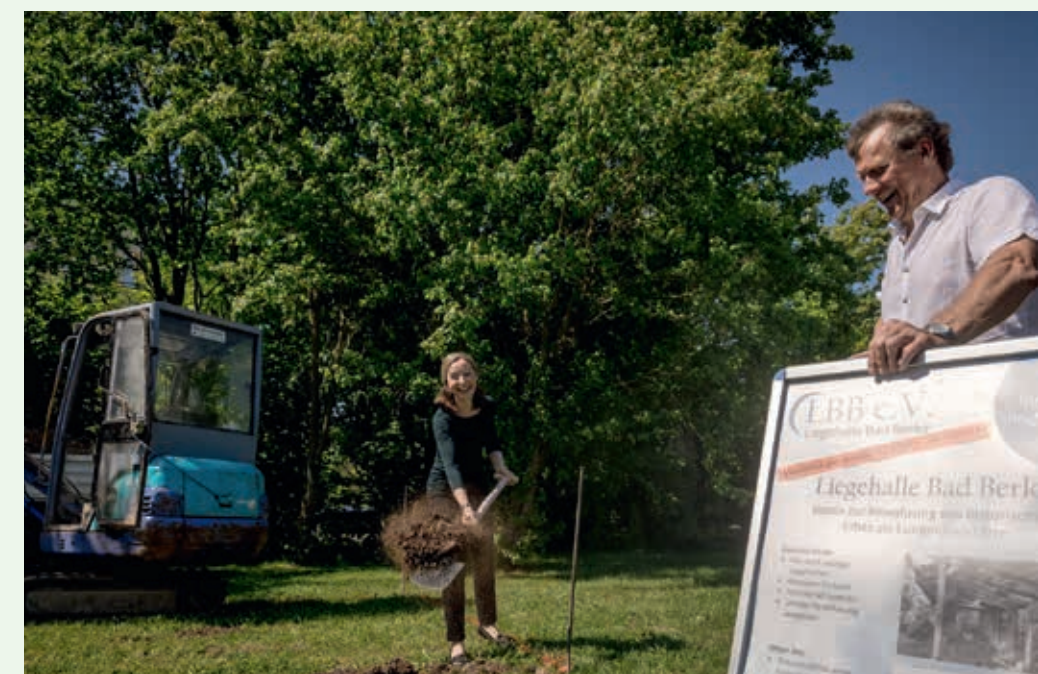
Dr. med. Antje Witzleb von Verein »Liegehalle Bad Berka« startete mit dem ersten Spatenstich die Arbeiten für den Nachbau der historischen Liegehalle.
